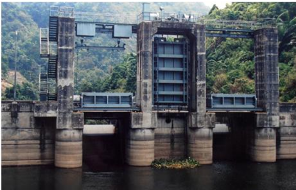
Gambar 6. Bendung pengendali Siruar, mengendalikan aliran keluar ( outflow ) dari Danau Toba ke Sungai Asahan, hingga Danau Toba tidak lagi berfungsi sepenuhnya sebagai danau alami.
