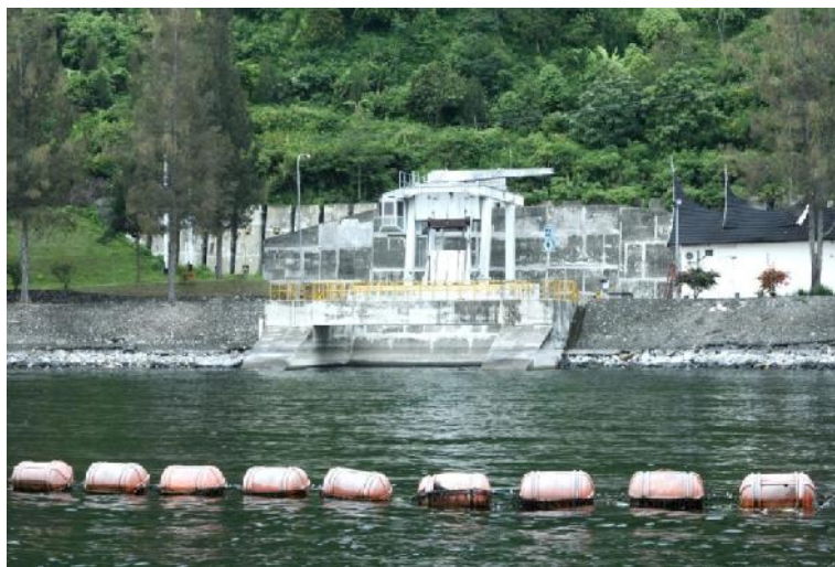
Gambar 4. Intake PLTA Singkarak di nagari Guguk Malalo. (Coubout, 2014)
